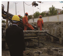
图3 钻孔机施工图
